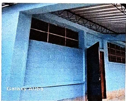
Foto 3. Las puertas están reparadas e instaladas y se pintó con color negro.
